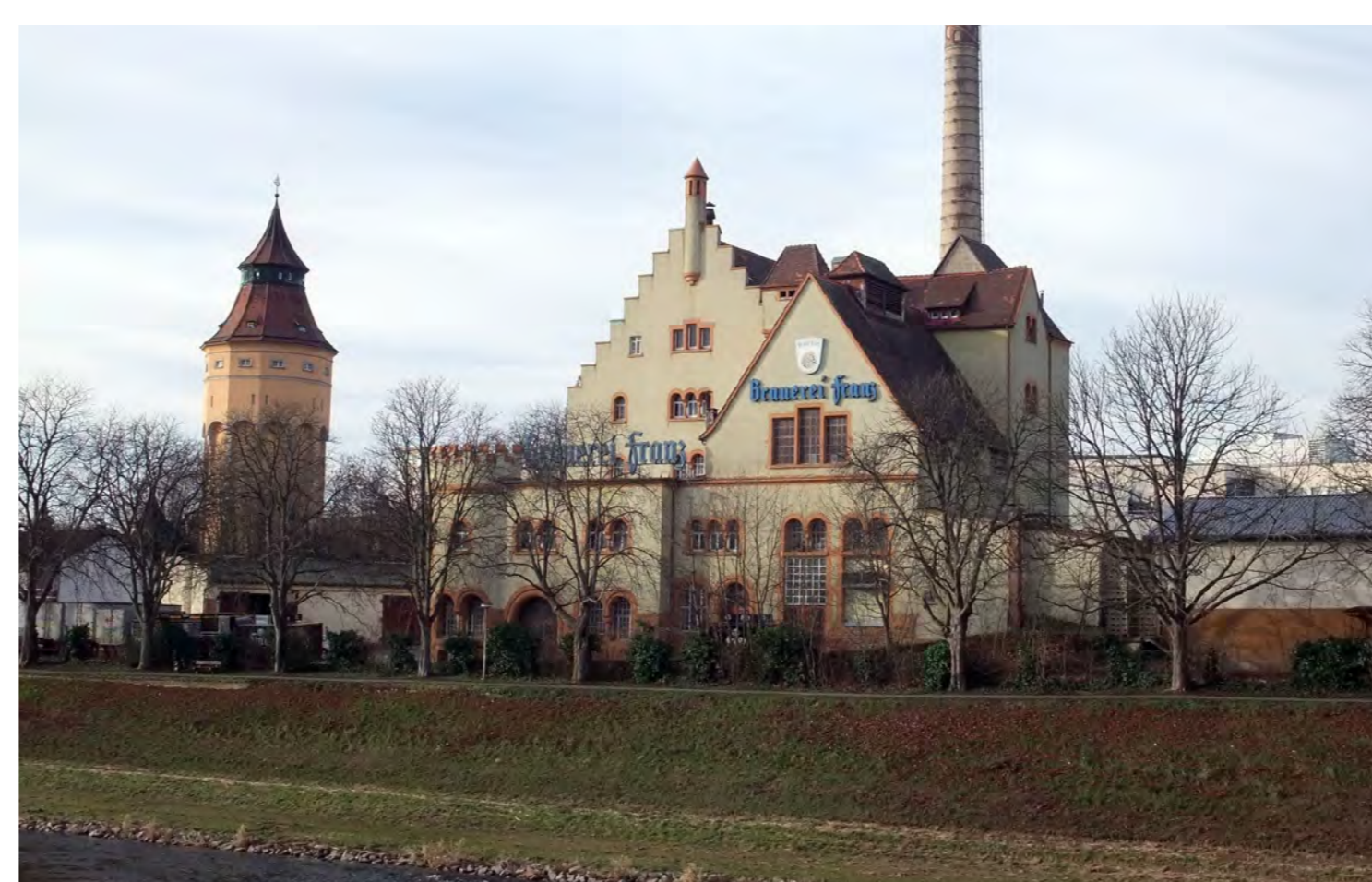
3.1 Ansicht von der Murg (Bestand)
