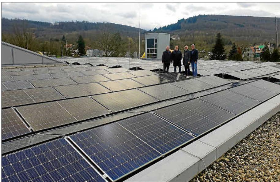
Eine von zwei Photovoltaikanlagen, die 2022 von der Bürgerenergiegenossenschaft in Betrieb genommen wurden, ist die Anlage auf dem Dach des Albgau-Hallenbads mit maximal 300 kWp Leistung.
