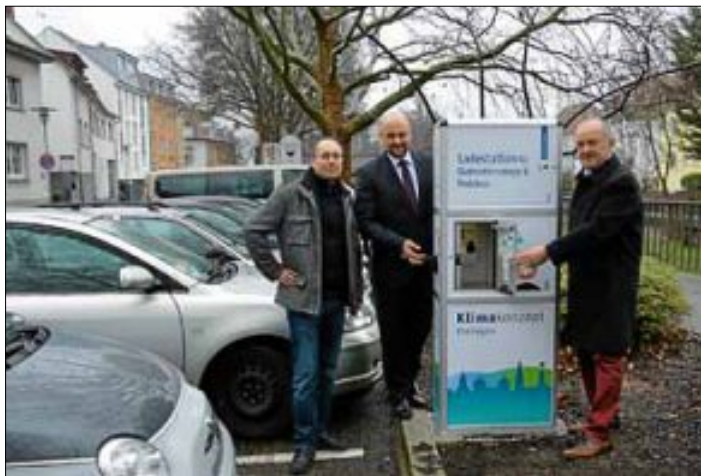
Die 8. Stromzapfstelle im Stadtgebiet Ettlingens wurde vergangene Woche in der Mühlenstraße Ecke Schillerstraße von Klimaschutzmanager Prosik, OB Arnold und Stadtwerkechef Oehler eingeweiht.
