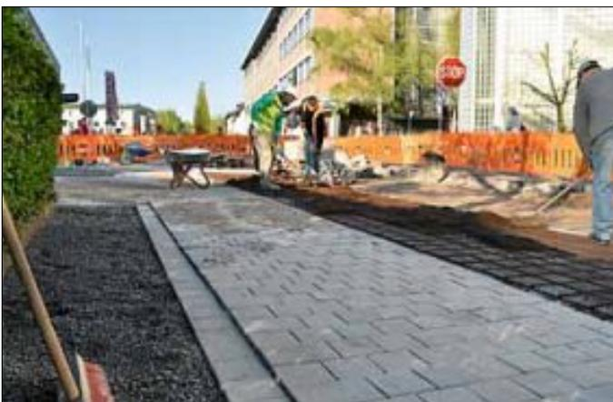
*Erstmals wird bei einer Straßenbaumaßnahme in Ettlingen ein atmungsaktiver Belag im Wurzelbereich der Bäume eingebaut.*
