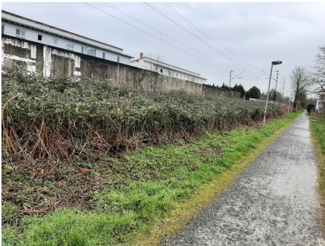
Abbildung 6: Fläche 004 zwischen km 82,2 und km 82,3
