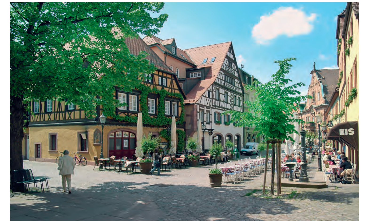
23/4 Kirchplatz: Objektsanierung des Weißburger Hofes
