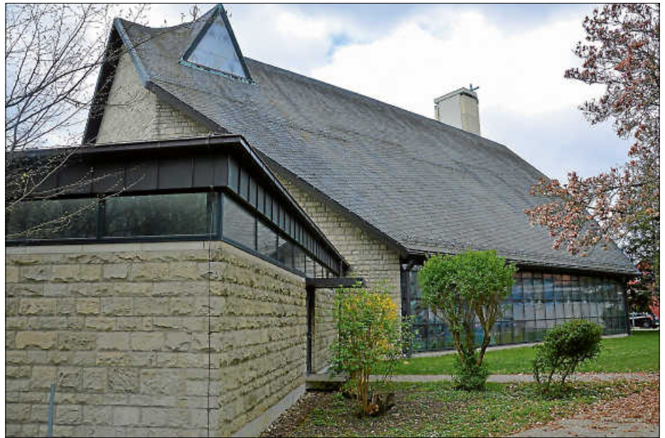
1964 wurde die katholische Liebfrauenkirche in Ettlingen-West geweiht, umfassende Renovierungsarbeiten sind mittlerweile notwendig geworden.
