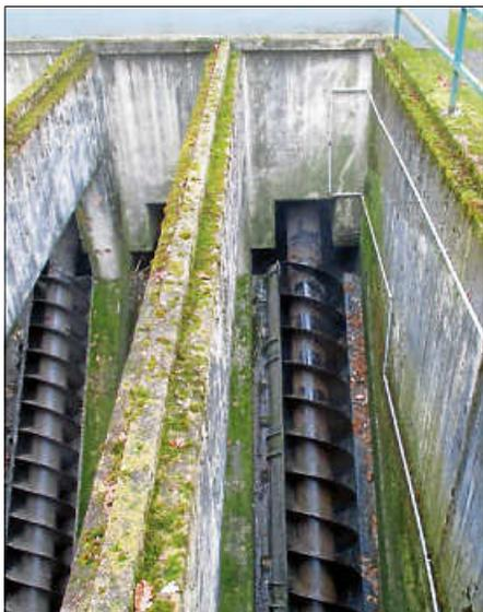
So sehen Abwasser-Förderschnecken aus, Beispiel aus einer anderen Hebeanlage.
