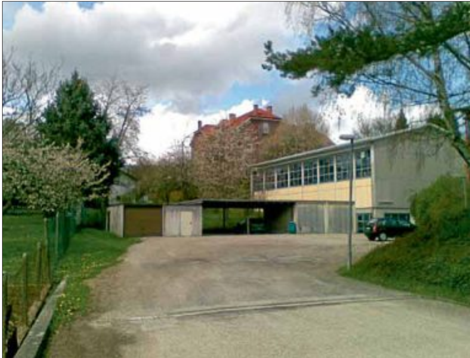
Sanierungsbedürftig ist die Schulturnhalle der Johann-Peter-Hebel-Schule, deren Erweiterung ebenso im Mittelpunkt der Bürgerinformation stand wie der Verkehr in Schöllbronn.
