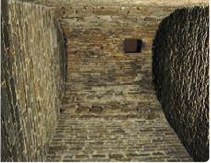
Blick in das Gewölbe des mittelalterlichen Bergfrieds
