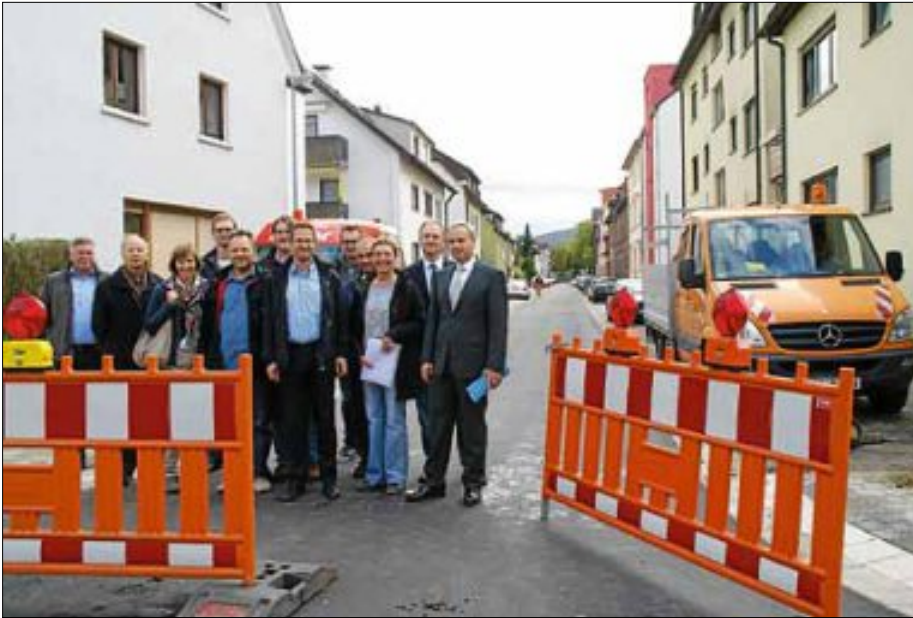
Am Donnerstag vergangener Woche wurden die letzten Baken von Planern, Ingenieuren und der bauausführenden Firma in der Zehntwiesenstraße zur Seite gestellt.
