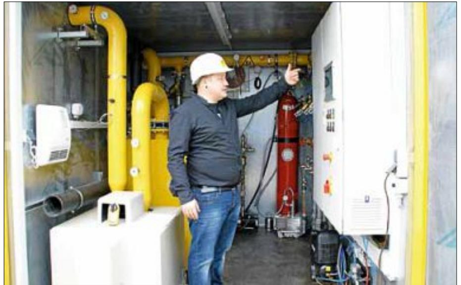
In die nächste Stufe geht die Sanierung des AKW-Schadens in der ehemaligen Rheinlandkaserne. Nach der Phasenentfernung folgt nun die Bodenluftabsaugung, zunächst im Testbetrieb. Bauleiter Wenzel der Firma Züblin erläutert die dafür notwendige Maschinerie.
