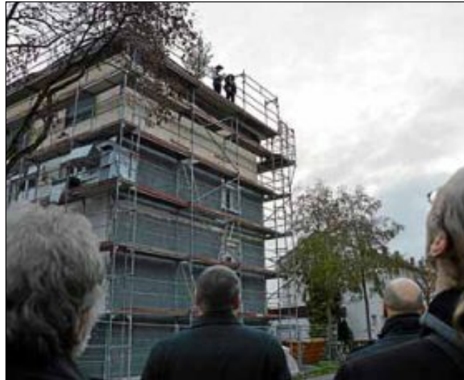
Richtfest von hoher Warte aus: durch die Aufstockung des Gebäudes um ein Stockwerk standen die Zimmerleute beim Richtspruch in luftiger Höhe.
