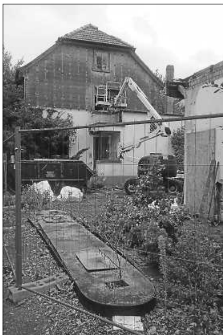
Abrissarbeiten in der Landstraße
