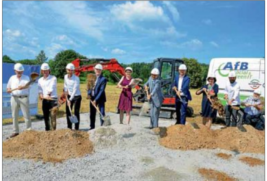
Beim Spatenstich würdigten Landrat Schnaudigel und OB Arnold den Einsatz des IT-Unternehmens AfB für die Umwelt und das Bekenntnis des Gründers zu Ettlingen durch den ressourcenschonenden Neubau im Industriegebiet.
