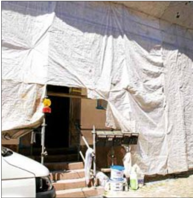
Nicht nur die Fassade wird saniert, auch das Treppenhaus. Eines der 432 Wohneinheiten im Besitz der Stadtbau GmbH.
