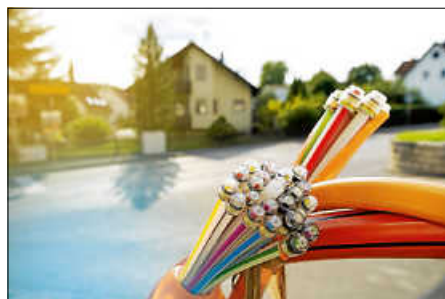
Foto: Dt. Glasfaser
