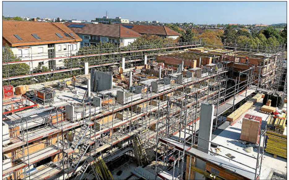
Der Neubau auf dem Festplatz wächst, im November kann dort schon Richtfest gefeiert werden.
