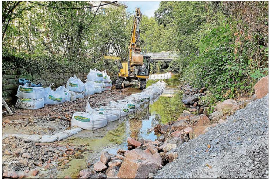
Tiefbauarbeiten am Wehr der Firma WACKHER sorgen noch bis zum November für zeitweise Trübung des Abwassers. Ziel der Maßnahme ist es, die alte Wehranlage für Fische passierbar zu machen, sowohl albaufwärts per Fischtreppe, als auch –abwärts mittels Fischrutsche. Das Foto zeigt den Blick vom Wehr albabwärts.
