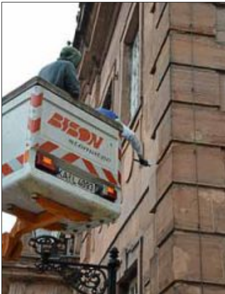
Abgesperrt wegen "Steinschlag"
