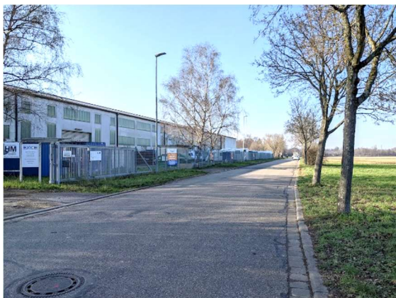
Bild 6: Bestandsbebauung am Hermann-Löns-Weg
