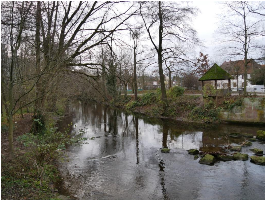
Abb. 9: Zustand der Alb an der geplanten Verkehrserschließung
