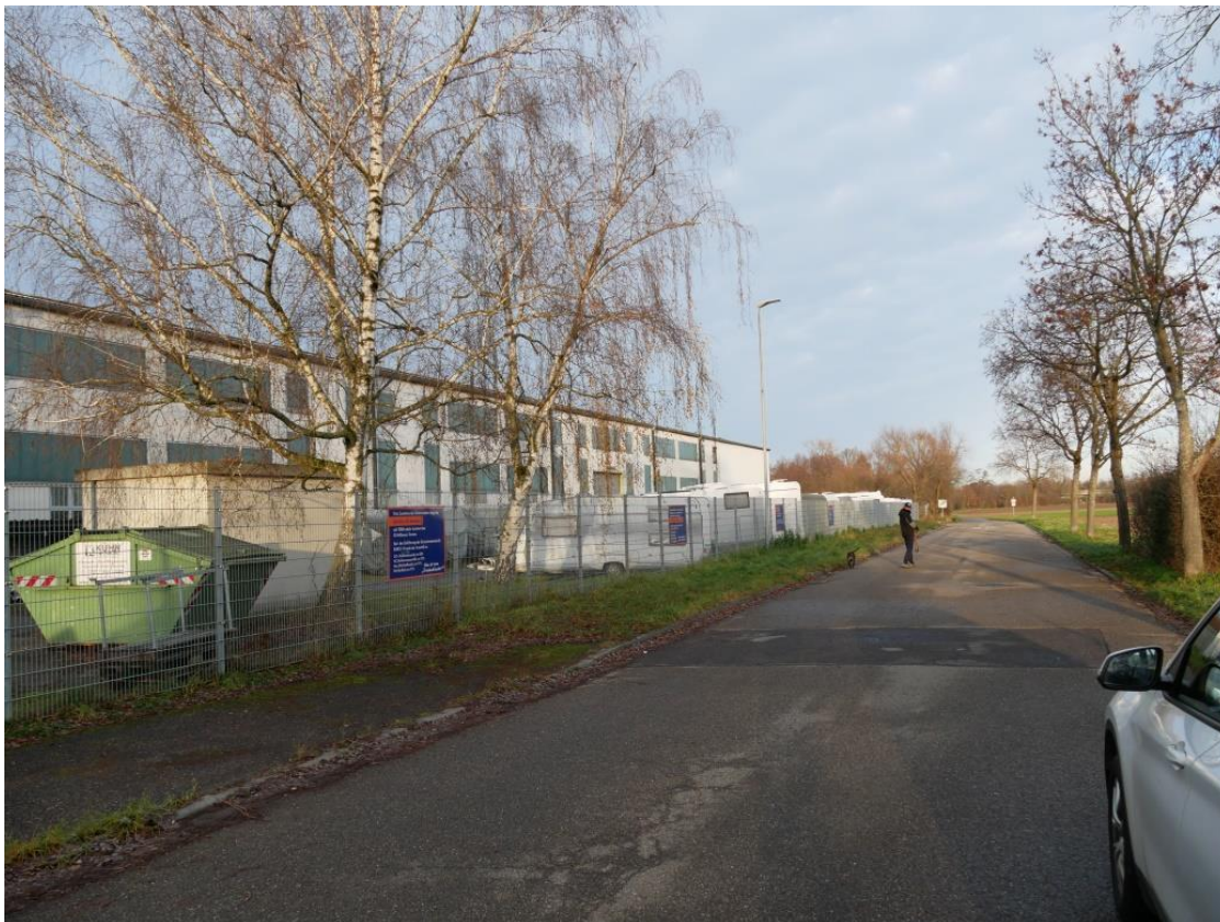
Abb. 5 Ehemalige Fabrikhalle mit Parkplätzen und ehemaligen Zierrasen
