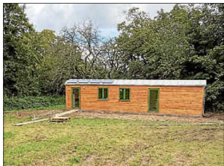
Der neue Bauwagen an steht an seinem Platz. Foto: Naturkindergarten Blattwerk
