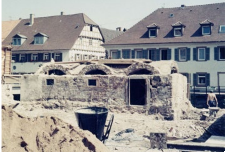
Freigelegter mittelalterlicher Salzkeller, Kirchenplatz 1
